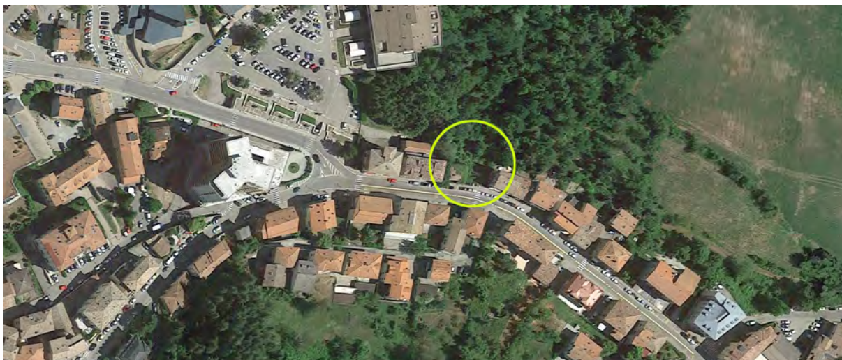
Vista aerea zenitale di Via Roma con indicazione dell'area di intervento (civico n. 48)
