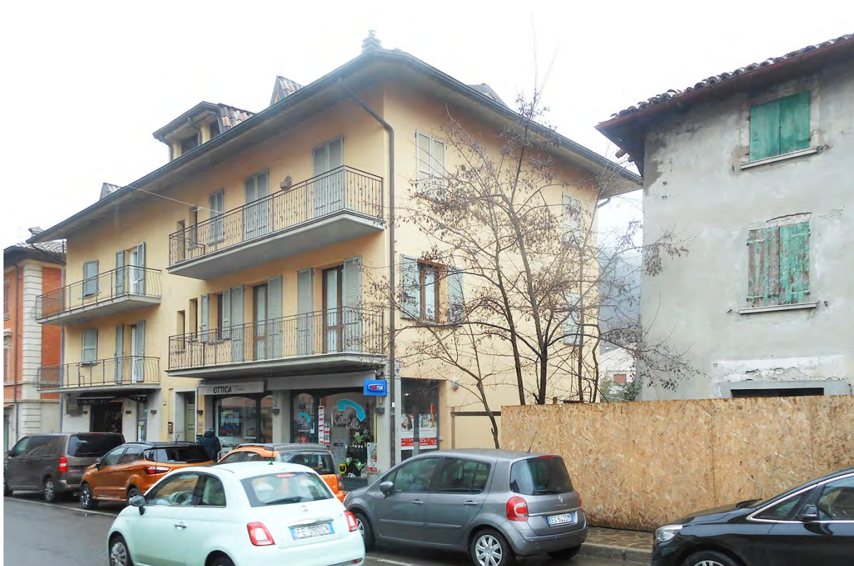
Immagine fotografica 03: vista dei posizionamenti reciproci fra edificio preesistente (prima della demolizione) e proprietà Simonazzi
