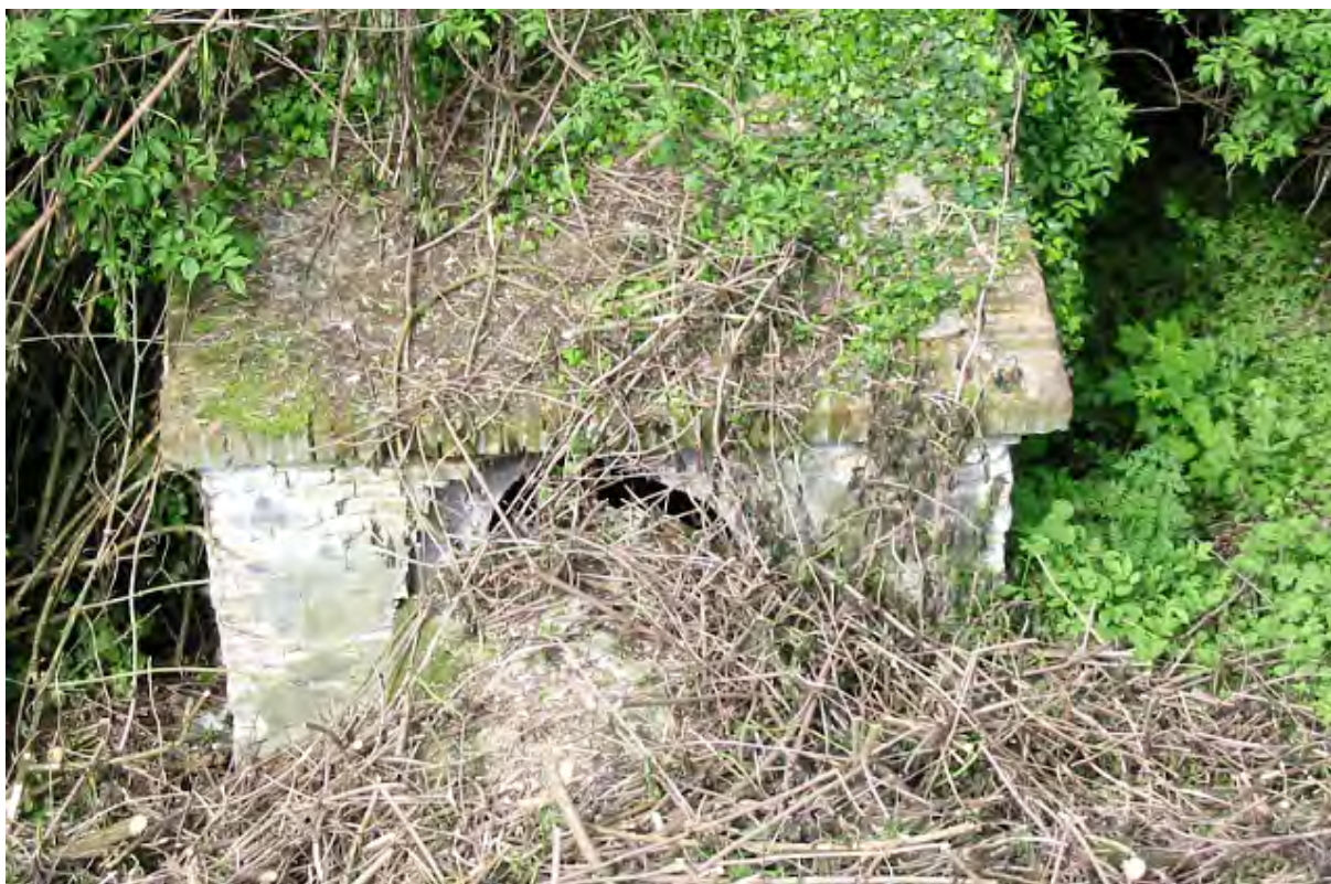
Immagine fotografica 11: uno dei pozzi del condotto scolmatore, gravemente danneggiato (condotto sconnesso)
