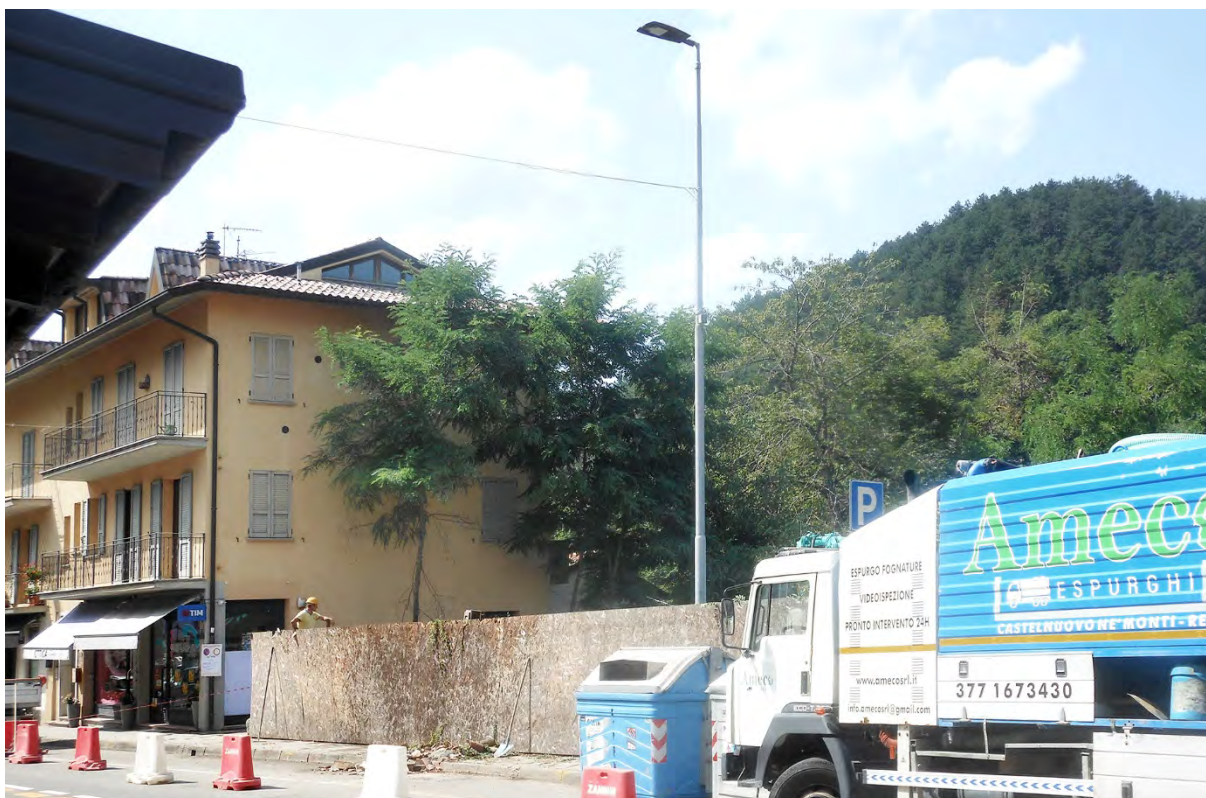
Immagine fotografica 16: il lotto dopo la demolizione dell'edificio pericolante su Via Roma (CILA 19/145, Prot. 10747 del 25/07/2019)
