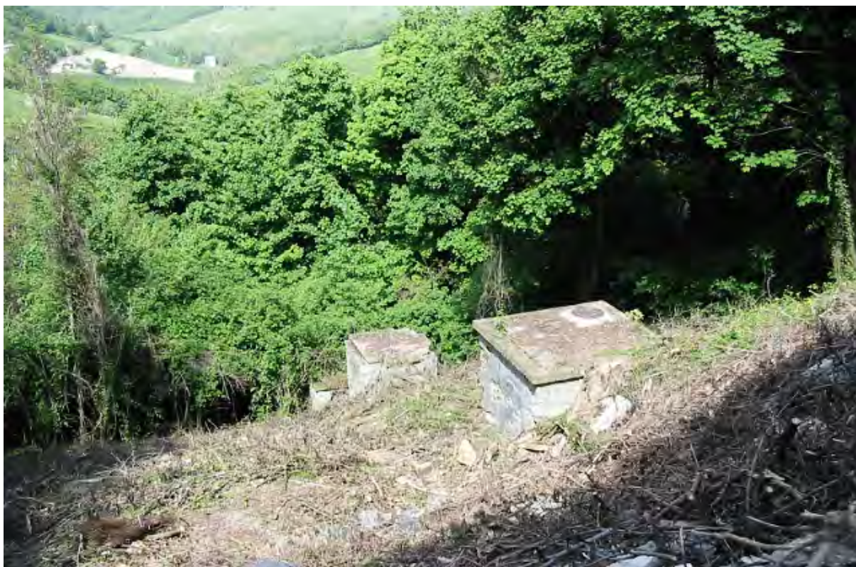
Immagine fotografica 10: il lotto verso valle; in evidenza i pozzetti in muratura del condotto scolmatore e la vegetazione di pendio
