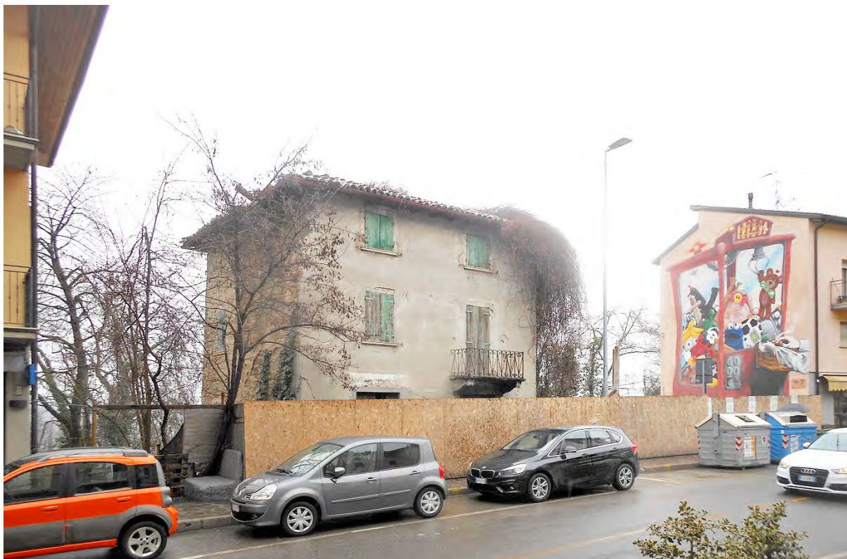
Immagine fotografica 02: vista del lotto di intervento da Via Roma (da ovest) prima della demolizione dell'edificio preesistente
