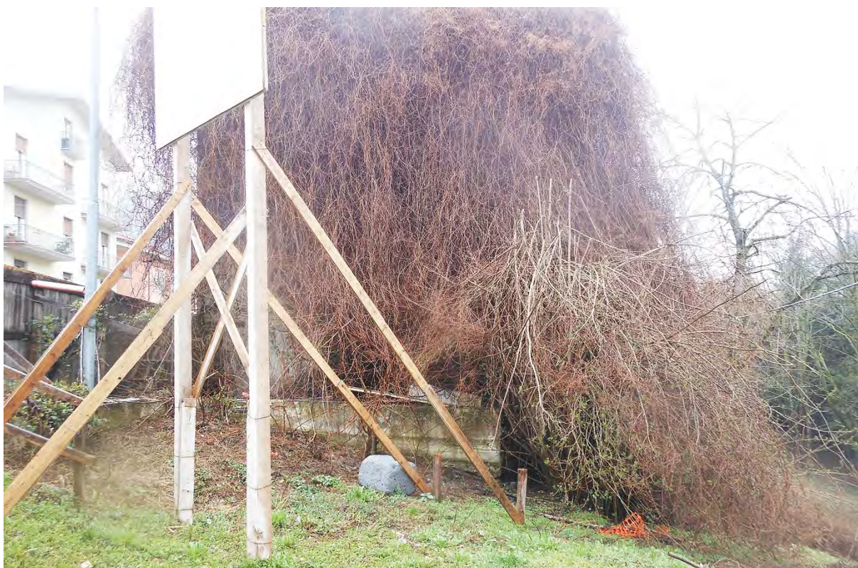
Immagine fotografica 05: il lotto di intervento (da est) prima della demolizione dell'edificio pericolante; a sinistra, Via Roma
