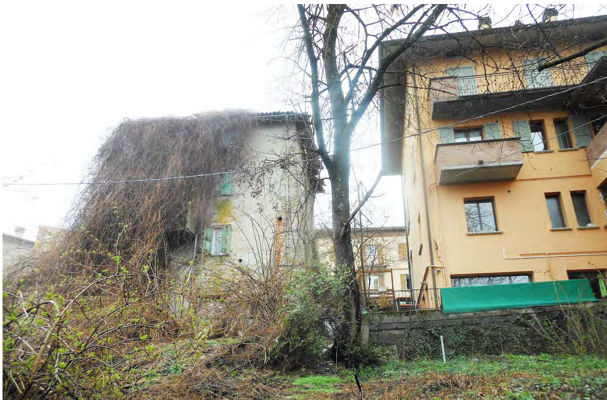
Immagine fotografica 08: vista del lotto di intervento da valle (da nord-ovest); sul fondo le facciate di Via Roma
