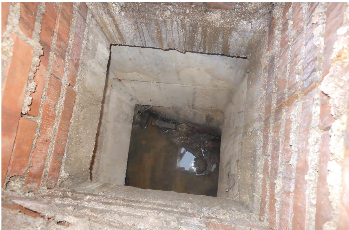
Immagine fotografica 12: interno del pozzetto di testa del condotto scolmatore, posto su Via Roma
