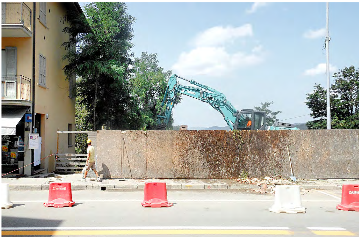
Immagine fotografica 15: l'ultimazione della demolizione dell'edificio pericolante (CILA 19/145, Prot. 10747 del 25/07/2019)
