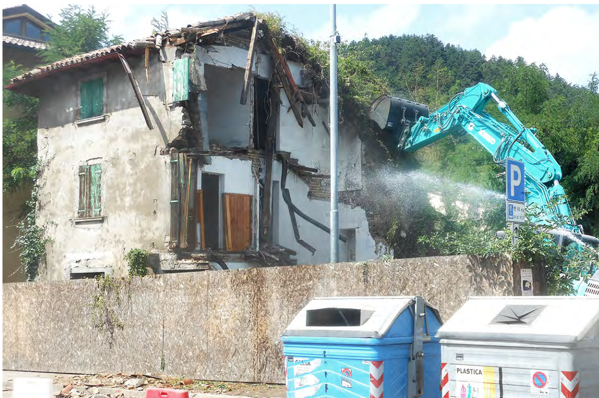
Immagine fotografica 13: le operazioni di demolizione dell'edificio pericolante (CILA 19/145, Prot. 10747 del 25/07/2019)
