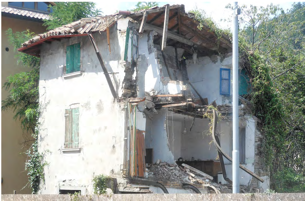
Immagine fotografica 14: le operazioni di demolizione dell'edificio pericolante (CILA 19/145, Prot. 10747 del 25/07/2019)
