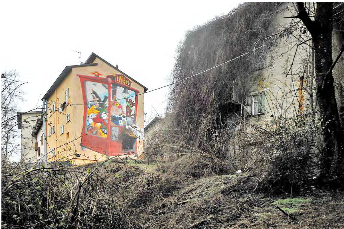
Immagine fotografica 09: vista del lotto di intervento da nord-ovest, prima della demolizione dell'edificio pericolante
