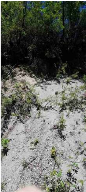
Foto 1: Affioramento di CTG nei pressi del sedime di progetto
