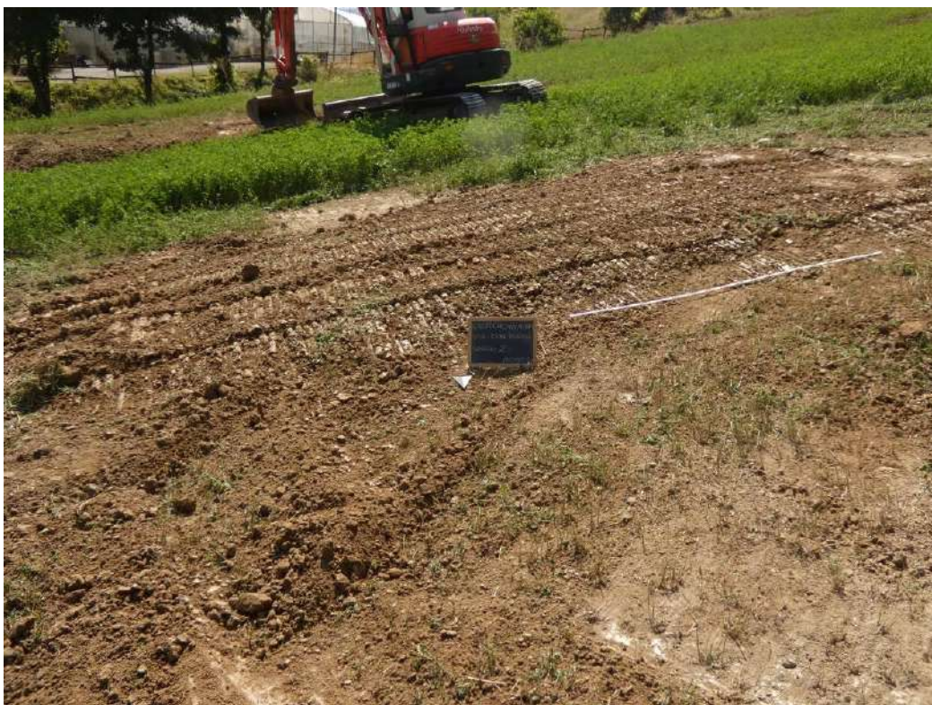
Figura 6 – Saggio 2 a inizio e fine lavori
