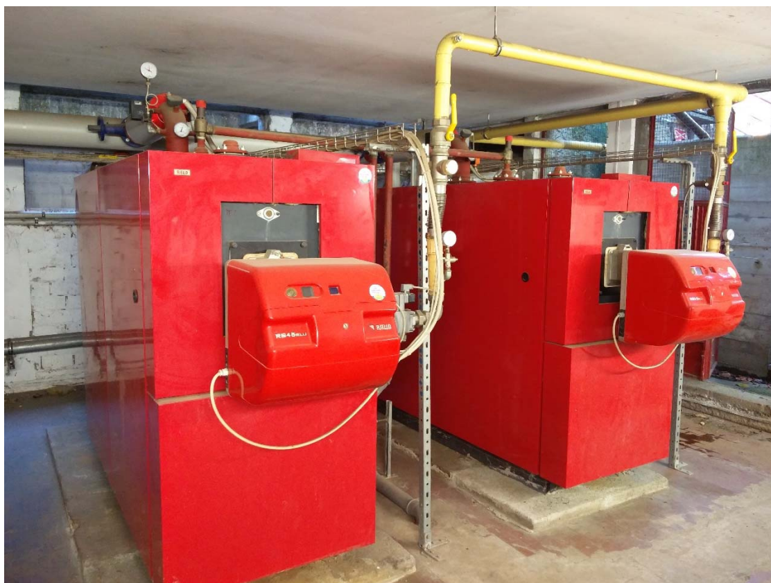
Fig. 7 – Caldaie a condensazione esistenti
