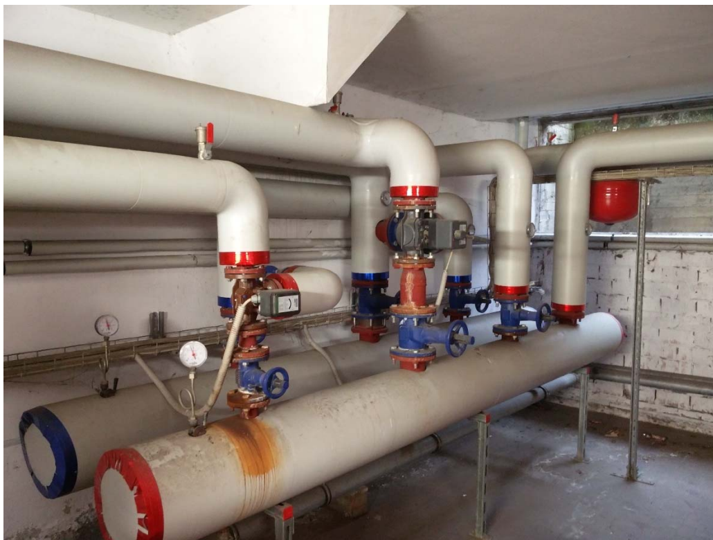
Fig. 8 – Collettore di distribuzione in centrale termica
