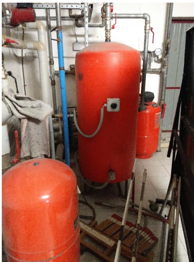
Fig. 10 – Serbatoio di produzione di acqua calda sanitaria
