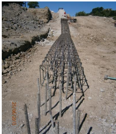
Le opere di perforazione del rilevato per la realizzazione dei pali in cls di consolidamento del terreno
