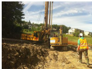
Le opere di consolidamento del versante tramite la realizzazione di berlinesi
