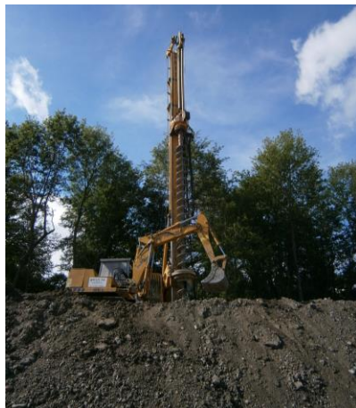
Le opere di perforazione del rilevato per la realizzazione dei pali in cls di consolidamento del terreno
