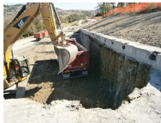
Le opere di consolidamento del versante tramite la realizzazione di berlinesi
