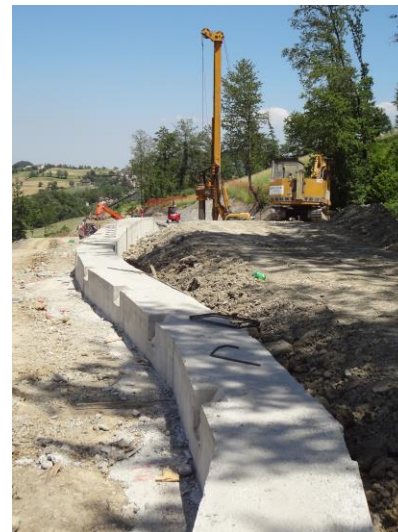
Le opere di armatura della trave di correa delle berlinesi propedeutiche alle opere di sbancamento del rilevato per la realizzazione del tratto infrastrutturale
