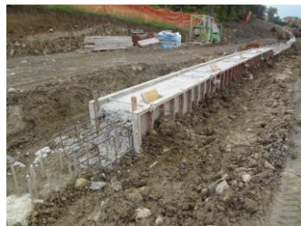
Le opere di consolidamento del versante tramite la realizzazione di berlinesi
