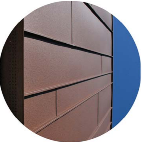
particolare rivestimento metallico/profilo microfoamato per araziolone.
