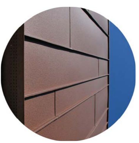
particolare rivestimento metalloprofilo microventilato per areazione.
