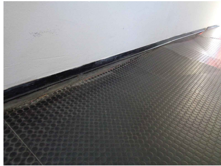
*7 : Sistemazione cedimento pavimento nel corridoio ingresso palestra
