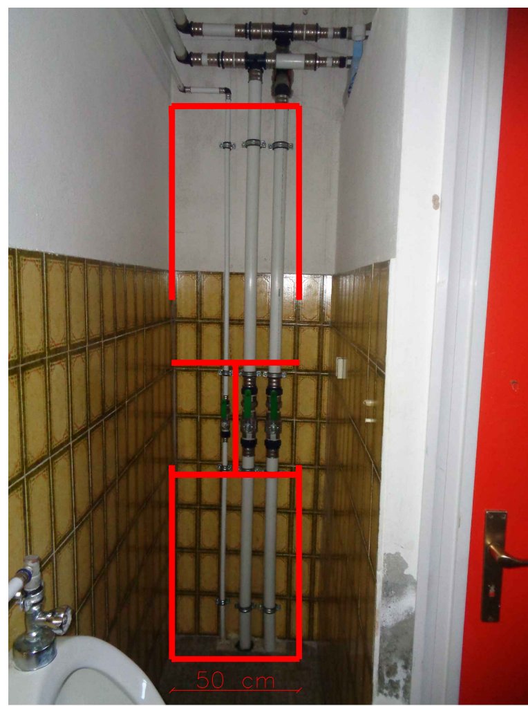
*4 : Sostituzione piastrelle e posa sottotraccia tubazioni
